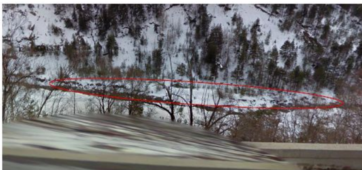
Figure 5 - Emprise sur parcelle E 140 - Photo depuis la route
