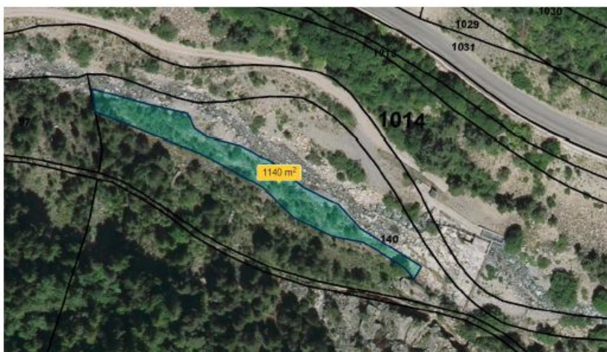
Figure 4 - Emprise sur parcelle 140 - Vue aérienne
